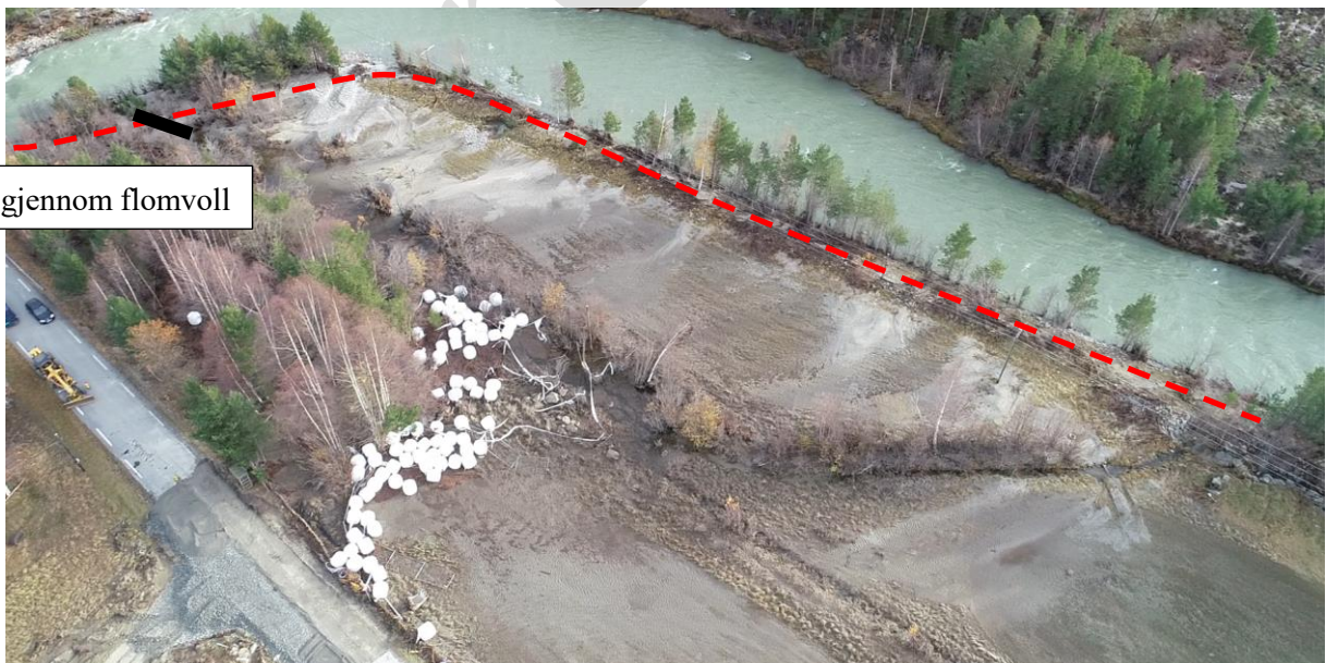
Reparasjon og forlengelse av flomvoll over en strekning på ca. 200 meter
